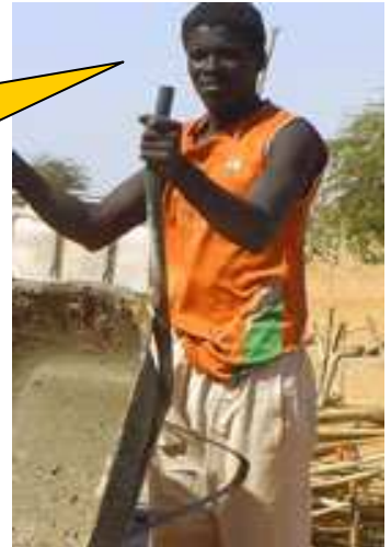
Un des ouvriers du chantier
